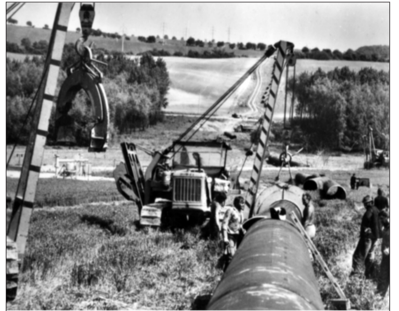
Stavba tranzitního plynovodu – spojení československé a sovětské částí u obce Ruská (okr. Trebišov) v dubnu 1977
